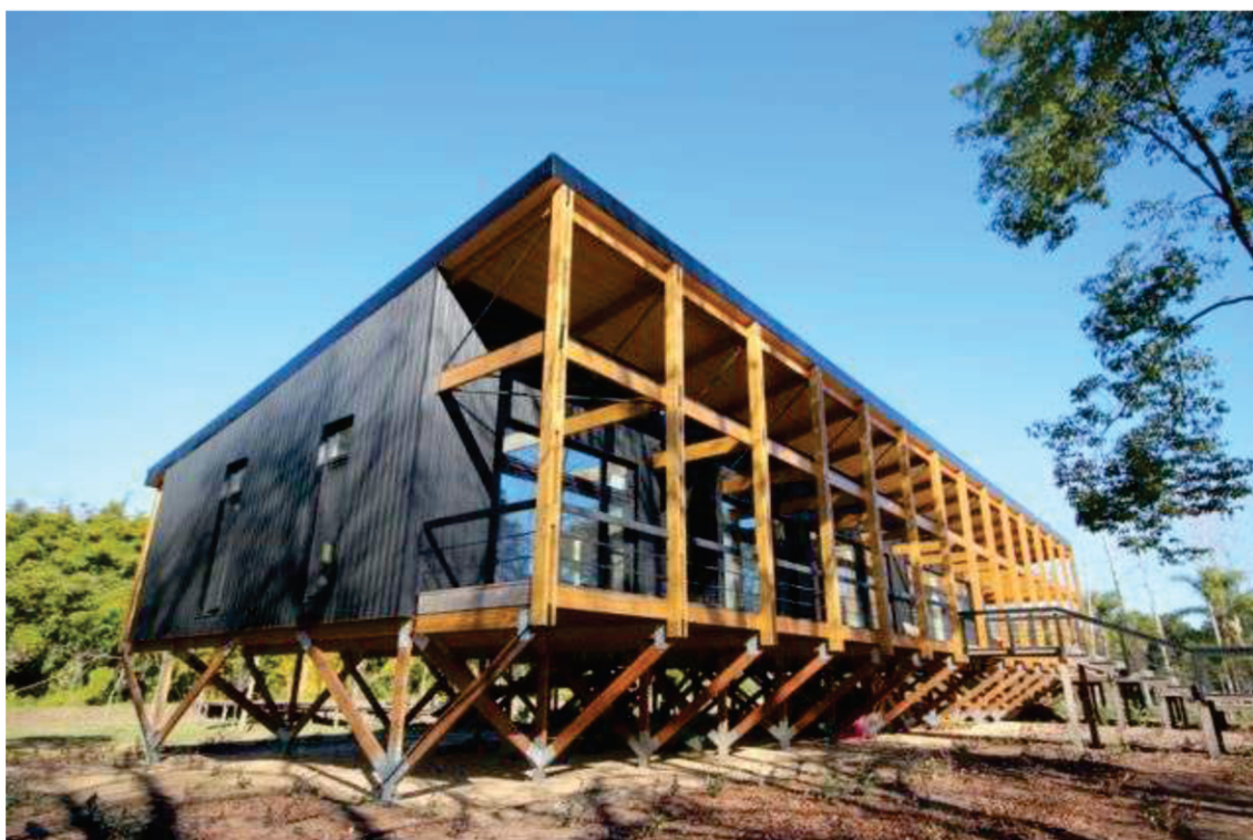
Casa passiva no delta do Rio Tigre, na Argentina, construída sobre pilares elevados para permitir as frequentes cheias do rio.
