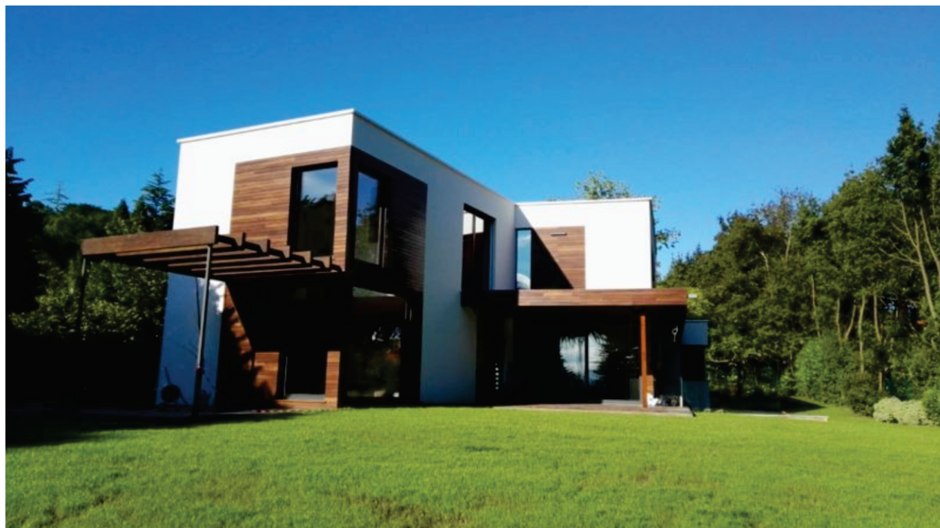
Moradia passiva nova nas Astúrias, Espanha.
